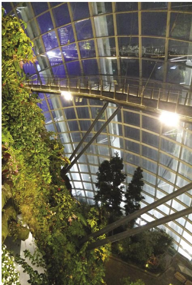
TROPIKALNY LAS W CHMURACH: 90% WILGOTNOŚCI I 2577 PANELI TWORZĄCYCH SZKLANĄ KOPUŁĘ O POWIERZCHNI 12 TYS. M KW.
