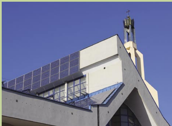
WIDOK NA DACH NOWEGO KOŚCIOŁA W JAWORZNIE-OSIEDLU STAŁYM
